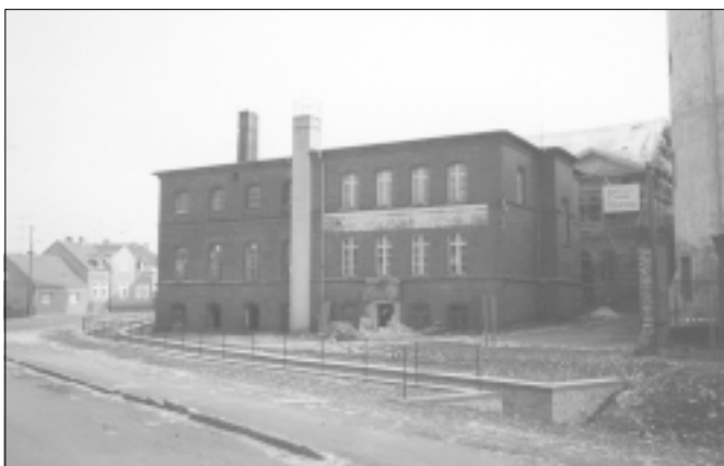
Vor dem Abriss der ehemaligen Wäscherei.
